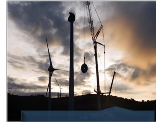
Levage de la nacelle
