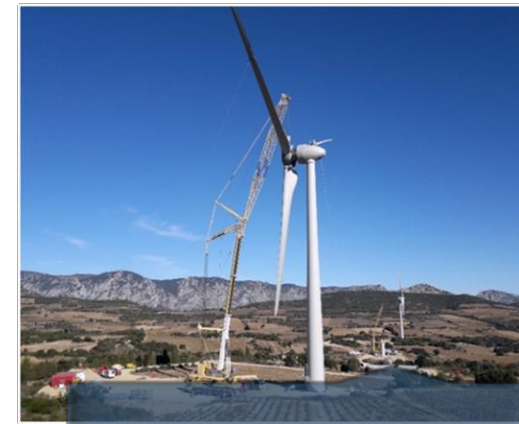
Levage du rotor
